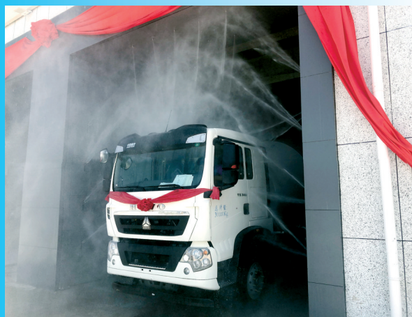
罐车在装载时,喷淋设备对全车清洗
