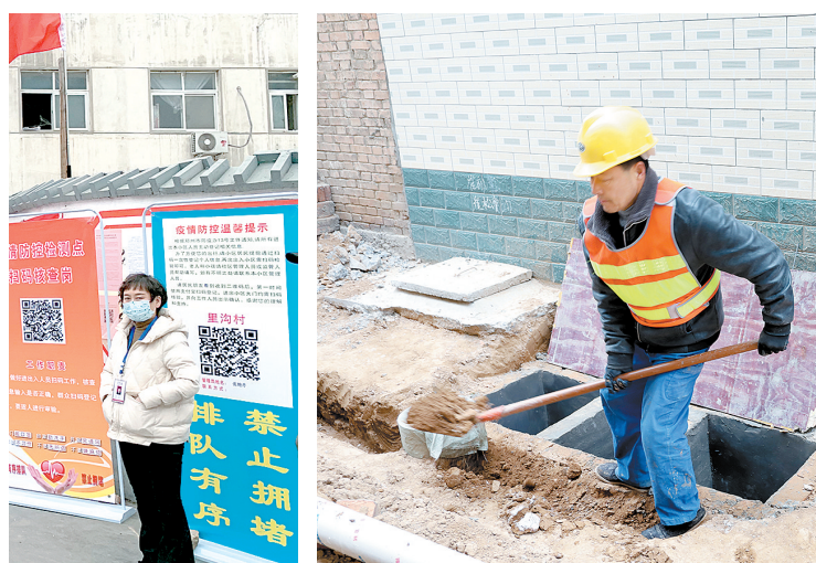
改水改厕施工现场
