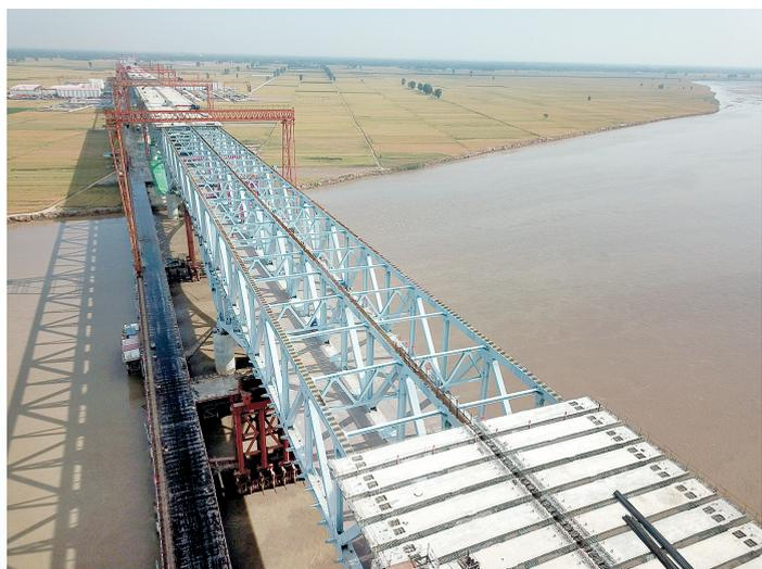
本报讯(郑报全媒体记者 曹婷/文 丁友明/图)昨日,随着最后一块钢梁准确对位,总重为7.28万吨,全长2016米的郑济铁路郑州黄河特大桥主桥全部钢桁梁,于上午10时16分顺利实现合龙。标志着郑济铁路的建设进入快车道,为实现全线贯通奠定了基础。该桥创下我国高速铁路无砟轨道钢混叠合连续钢桁梁大桥中长度最长、跨度最大、设计时速最高等3项纪录。
