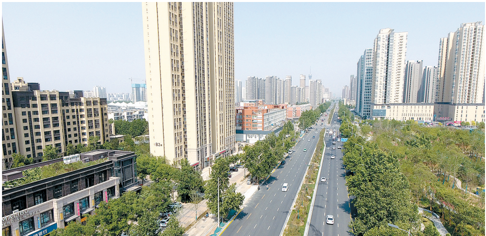
航海路道路综合改造工程示范段
