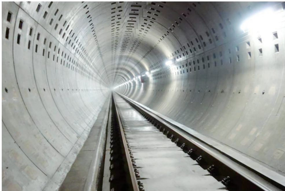
顺城街站至贾鲁河停车场区间实现单线轨通
