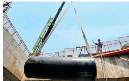
郑州自来水工程公司敷设桥南水厂配水管道施工现场
