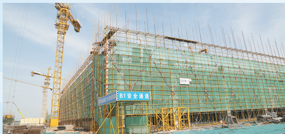
新郑市郭店镇传化物流小镇工地正在建设
