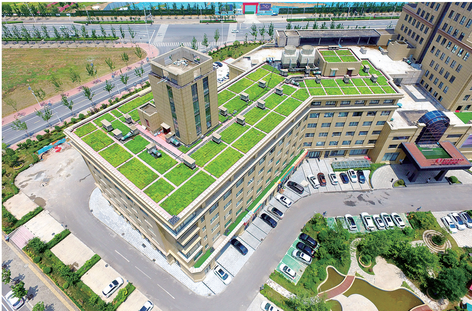
新郑市北区商会大厦楼顶绿化成为一道风景 郑报全媒体记者 杨宜锦 通讯员 王建伟 图
