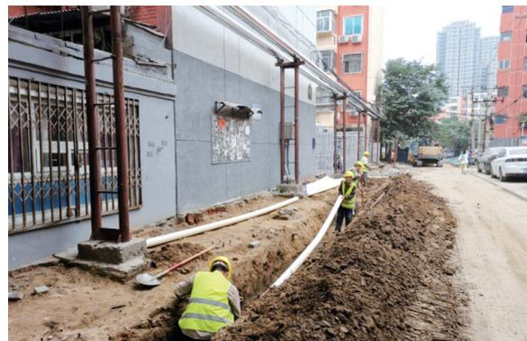
本报讯 汝河小区的旧小区改造中,针对管线杂乱的现象,积极牵头协调电信、移动、联通、广电等公司,由施工方进行施工,开挖道路、预埋管道、分拣线缆,虽然过程中也遇到一些困难,但各方配合得很好。目前管线入地改造项目正在持续进行中。
