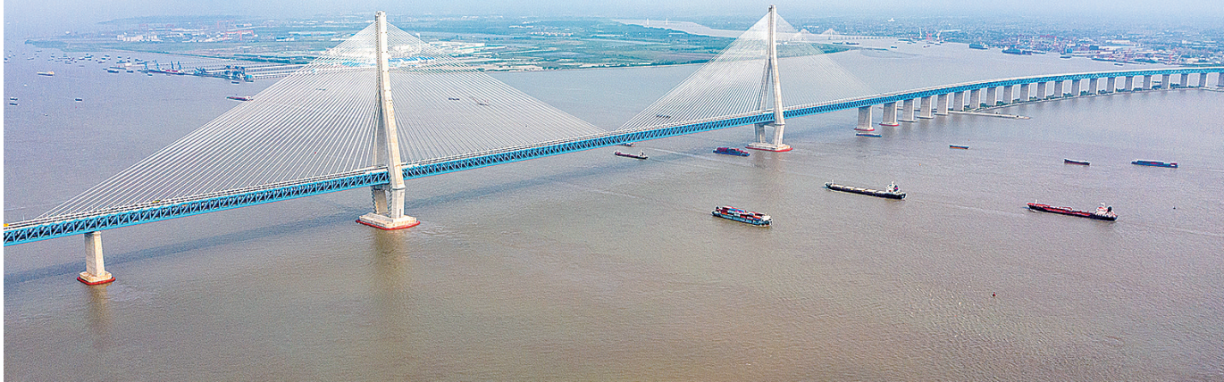
7月1日拍摄的沪苏通长江公铁大桥(无人机照片) 新华社发
