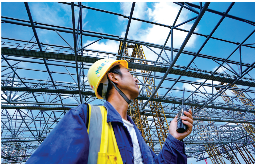
提升过程全程数字化操作,技术人员同时进行施工监控
