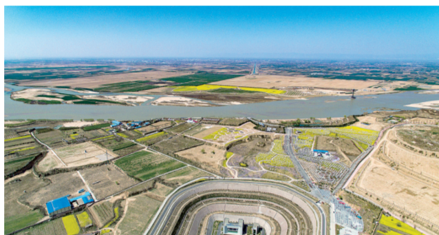
南水北调穿黄工程
