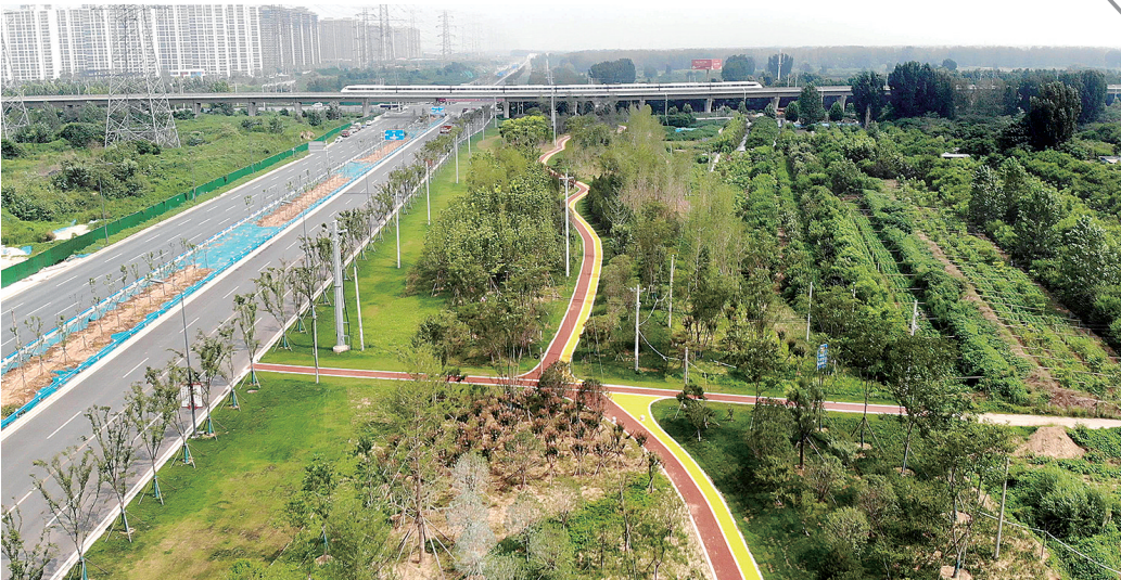
万三公路生态廊道
