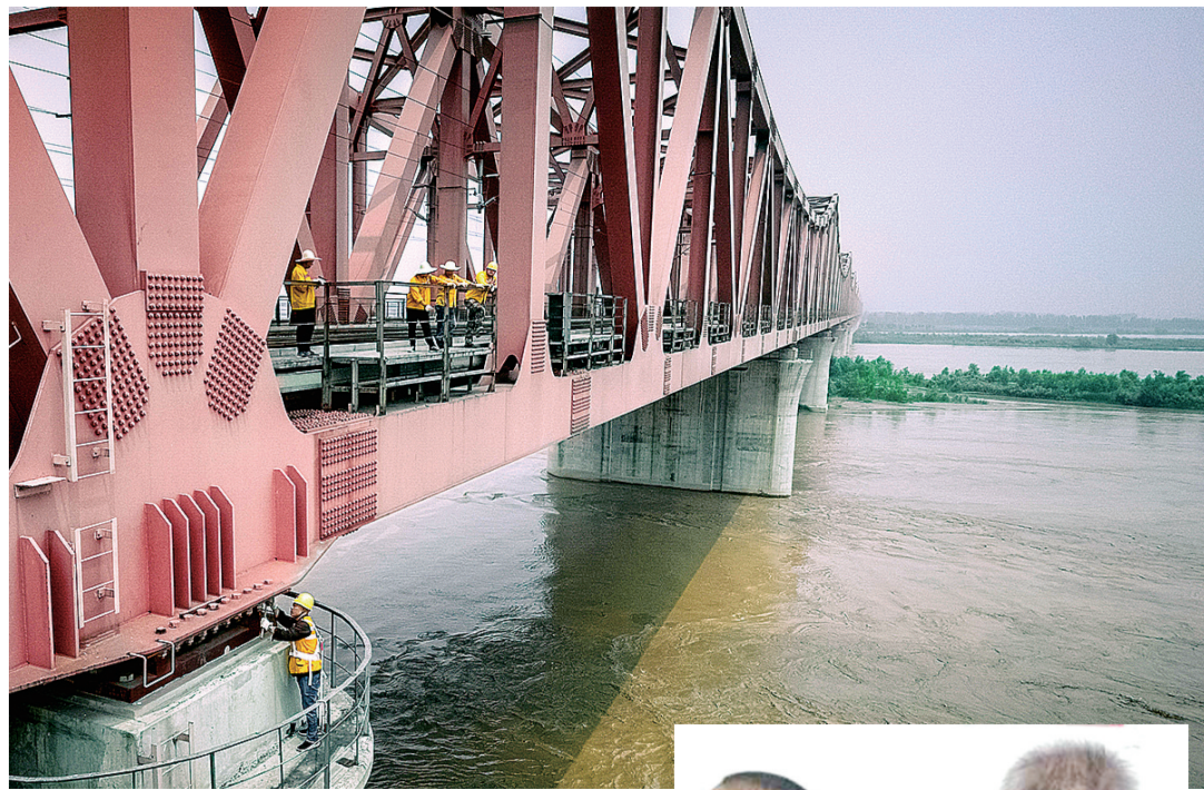
李小林和同事对黄河桥进行汛期检修
