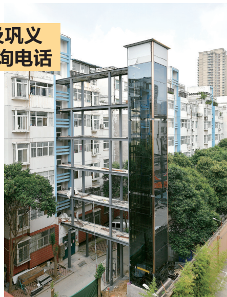
二七区兴华南街168号院加梯现场
