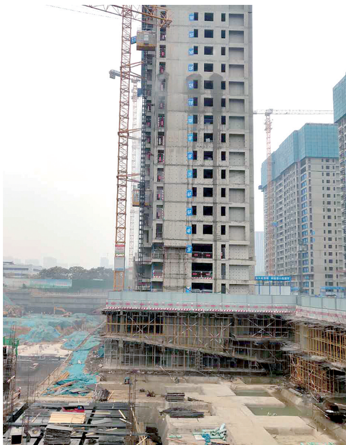
数码港四期工地项目
