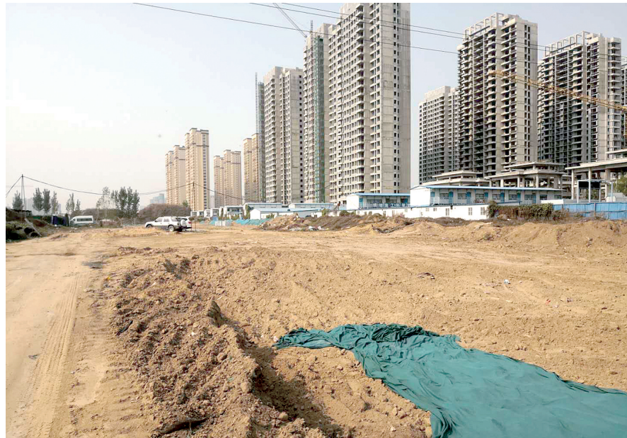
第十八大街第14条道路施工项目第三标段工地
