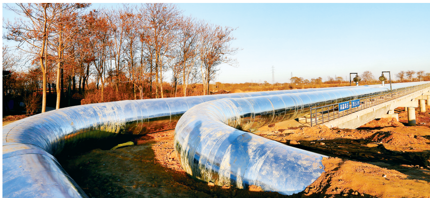
国电荥阳电厂热源入郑配套管网——索河桥管网
