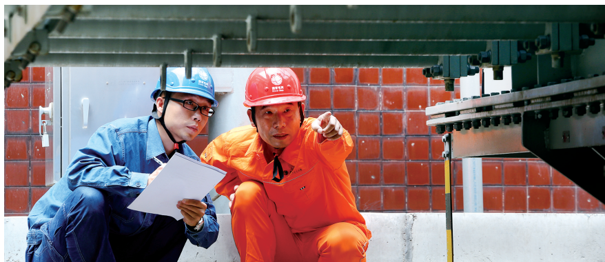
供电人员在检修设备
