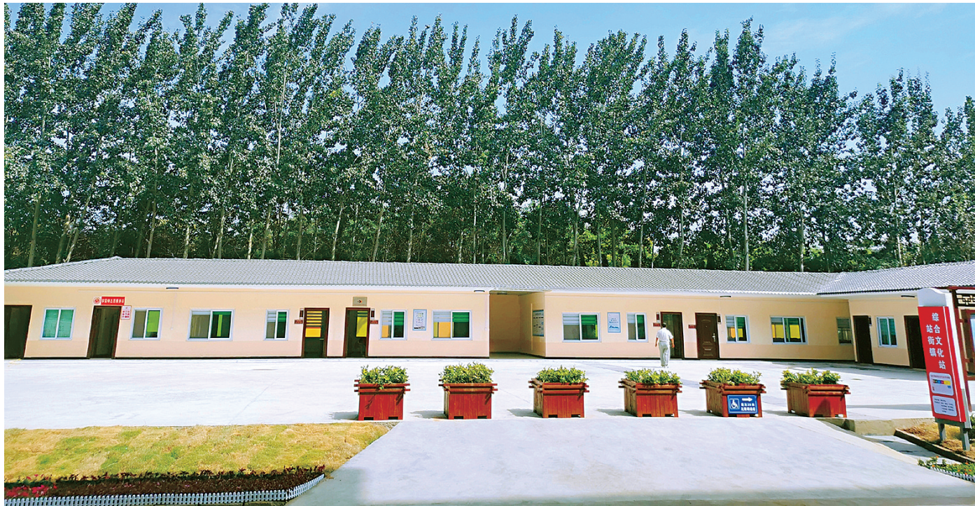
站街镇综合文化站
