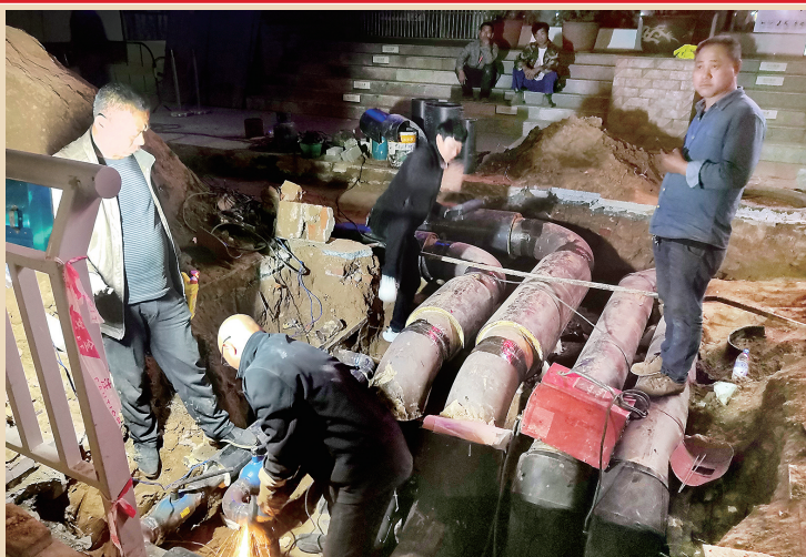
热力公司维修人员正在郑棉一厂加紧改造暖气管道 郑报全媒体记者 张华 图
