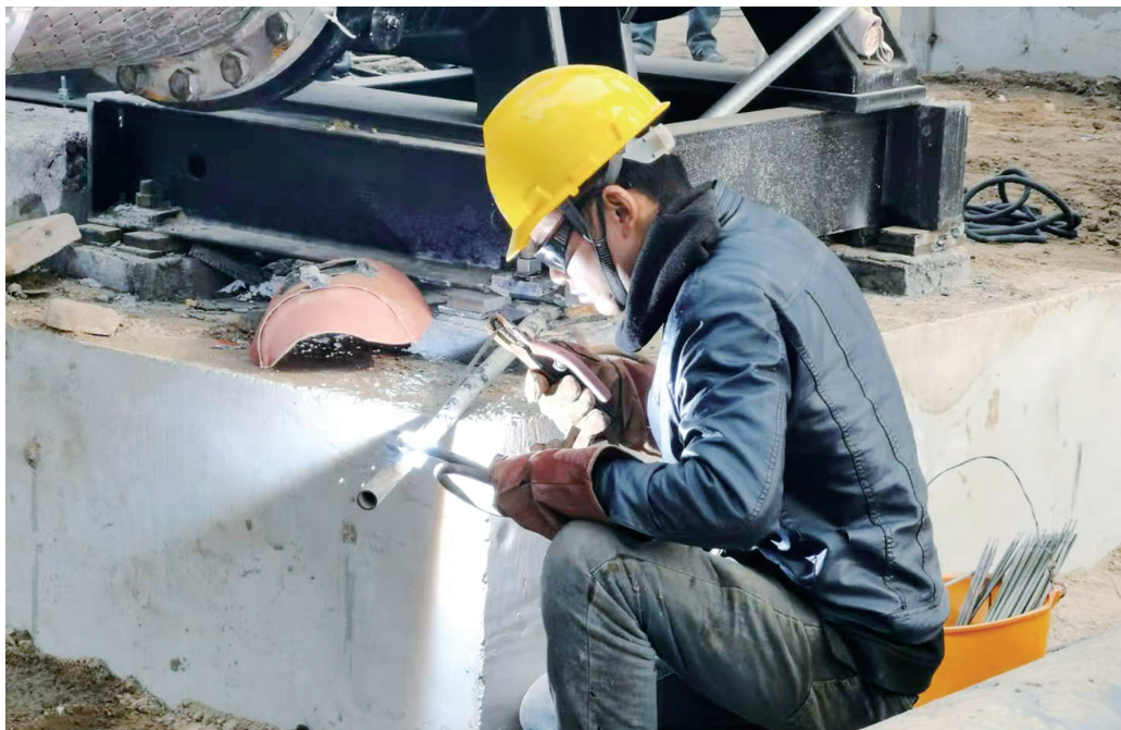
工人在抓紧施工
