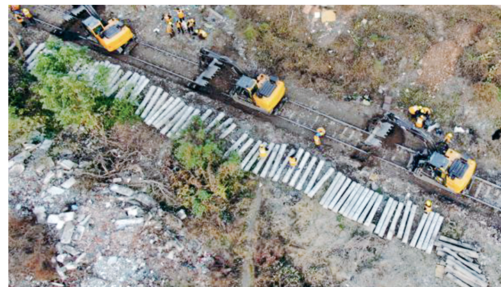
新型换枕车作业现场
