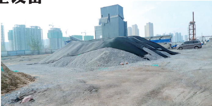
河南宏达路桥建设有限公司港区第一分公司
