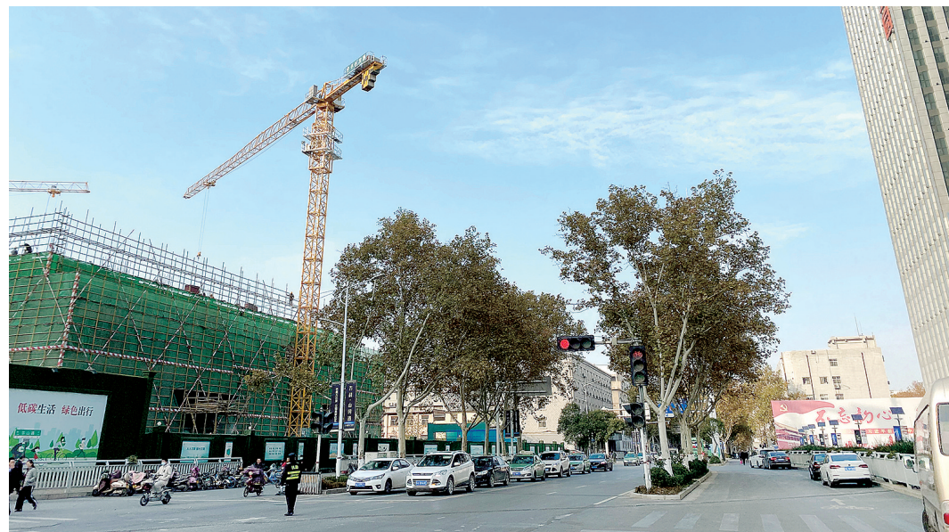
加强工地围挡管理,保持良好城市形象
