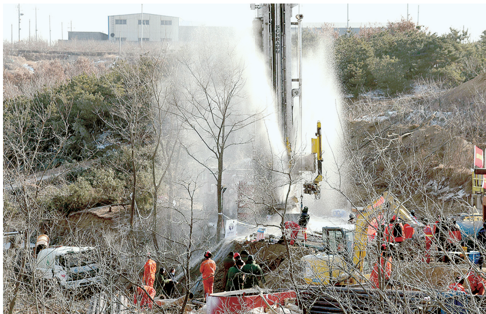
栖霞笏山金矿爆炸事故救援现场 新华社发
