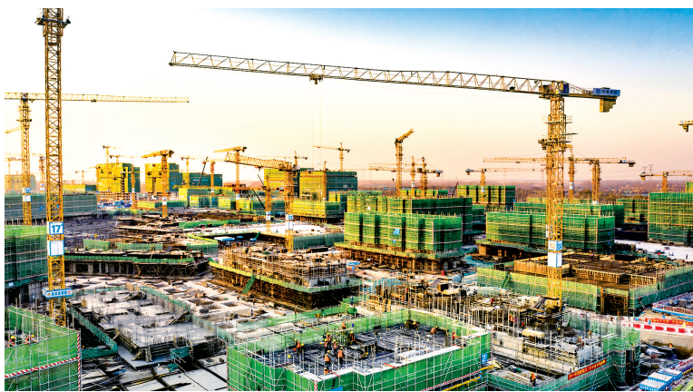
鲲鹏软件小镇建设中
