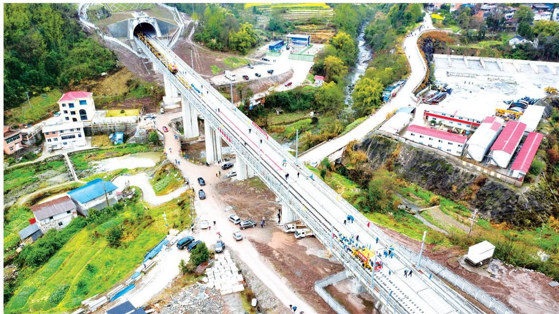
3月1日,在郑万高铁重庆段施工现场,施工人员在铺轨作业。当日,随着第一组500米长钢轨铺入无砟轨道,由中铁十一局负责的郑万高铁重庆段铺轨工程正式启动。
