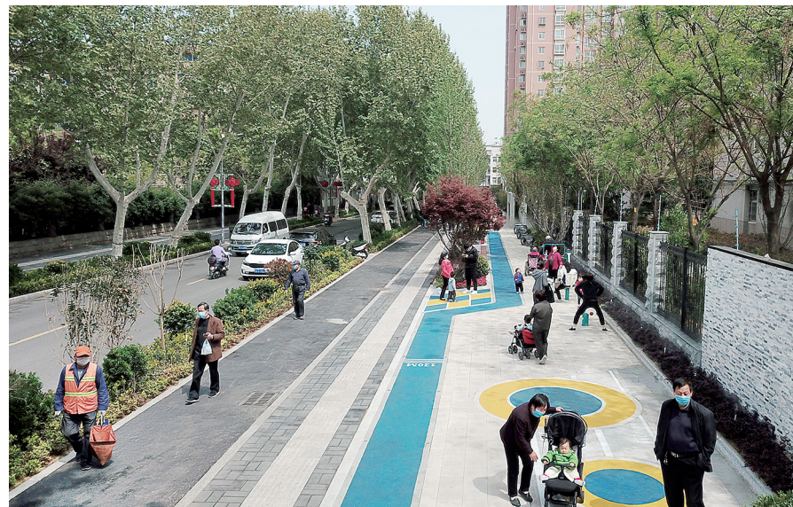
道路改造旧貌换新颜
