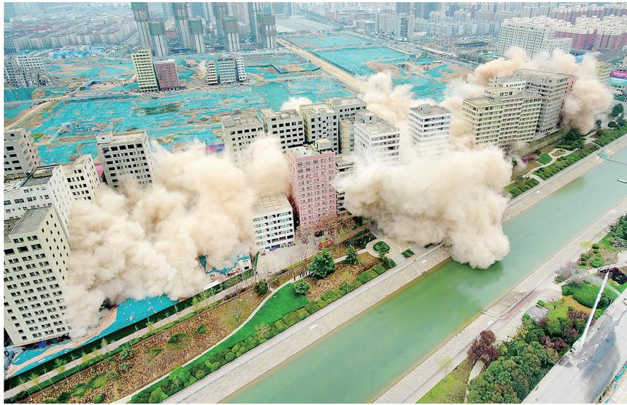
防尘网,最大限度降低施工过程中的扬尘。爆破后第一时间,提前准备好的12台水雾炮车、8台冲洗车驶入爆破区域,进行降尘。随后,环卫工作人员也开始清扫路面。此外,还配备大量的防尘水袋和防尘网,减少爆破扬尘范围和消散时间,将爆破对环境的影响降至最低。
