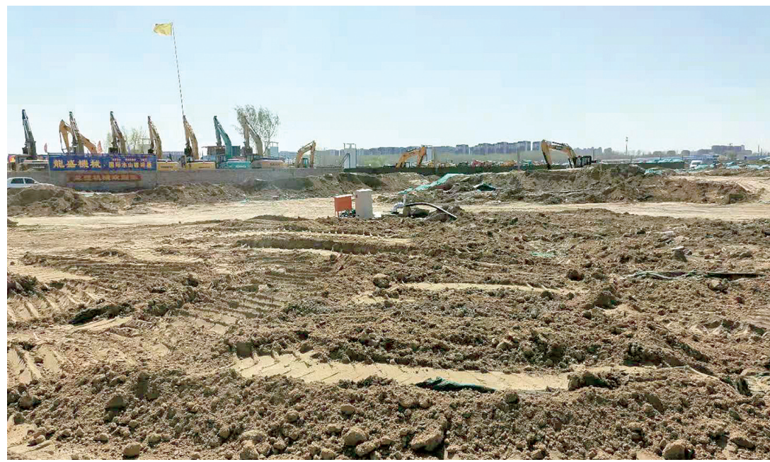
四环快速化大河路五标段工地
