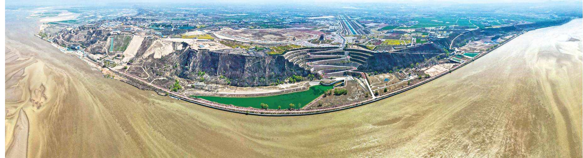
航拍丰乐樱花园和南水北调穿黄工程 郑报全媒体记者 李新华 图
