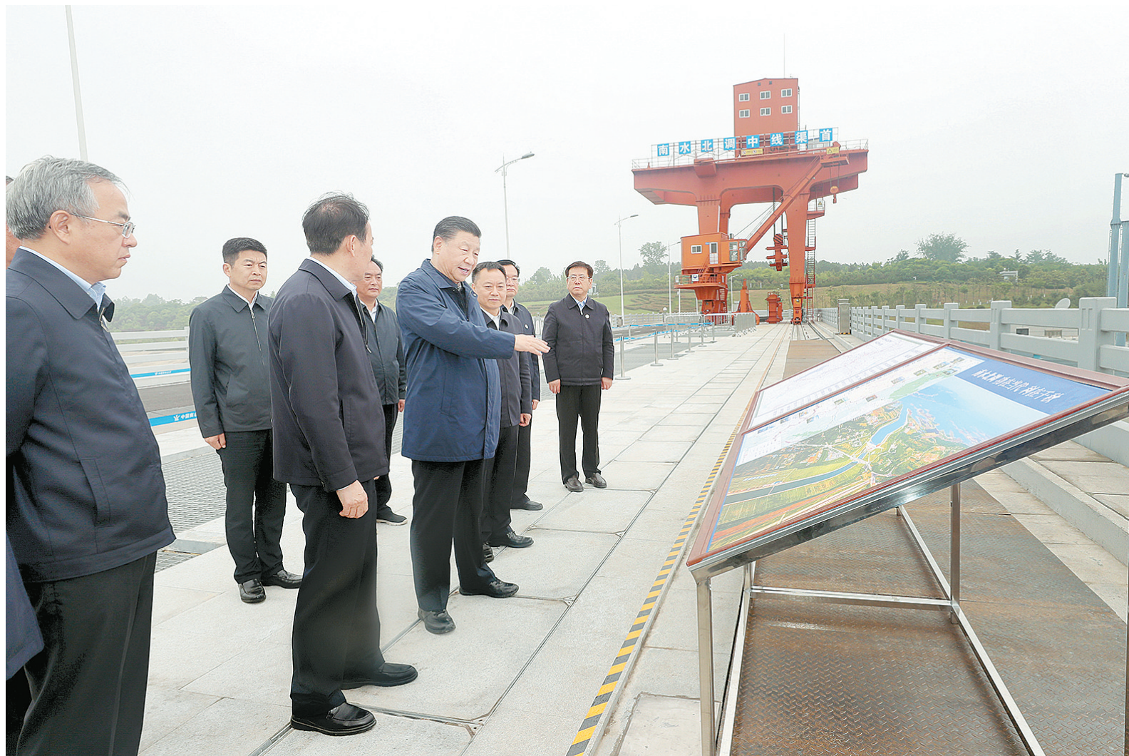
5月14日上午,中共中央总书记、国家主席、中央军委主席习近平在河南省南阳市主持召开推进南水北调后续工程高质量发展座谈会并发表重要讲话。这是座谈会前,习近平于13日在南阳市淅川县陶岔渠首枢纽工程察看引水闸运行情况。新华社记者 王晔 摄
