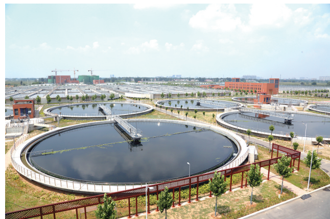
再生水处理系统
