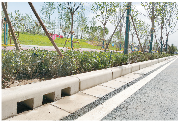
南四环萍湖路口附近的绿地雨水收集设施
