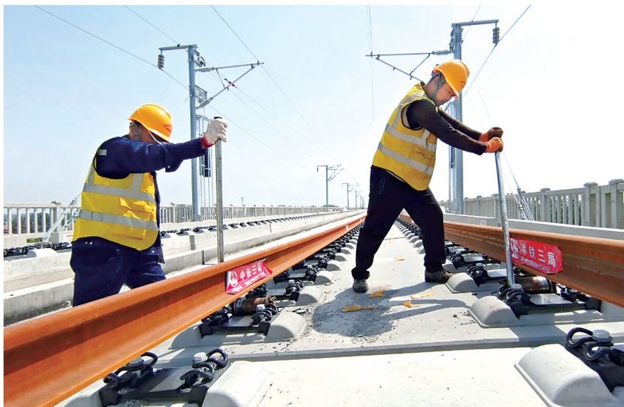
郑济高铁河南段铺轨作业现场
