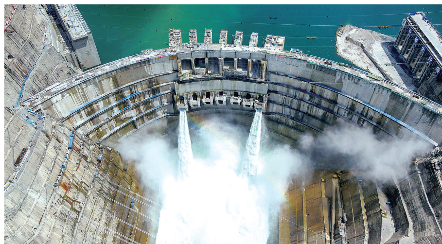
全球在建规模最大、单机容量最大、技术难度最高的水电工程——金沙江白鹤滩水电站首批2台机组投产发电 新华社发
