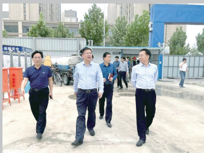
经开区党工委副书记、管委会主任李小虎视察学校建设工地
