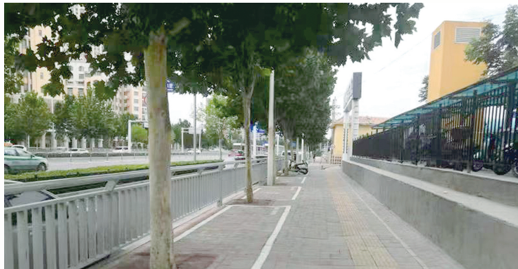
道路综合改造提升
