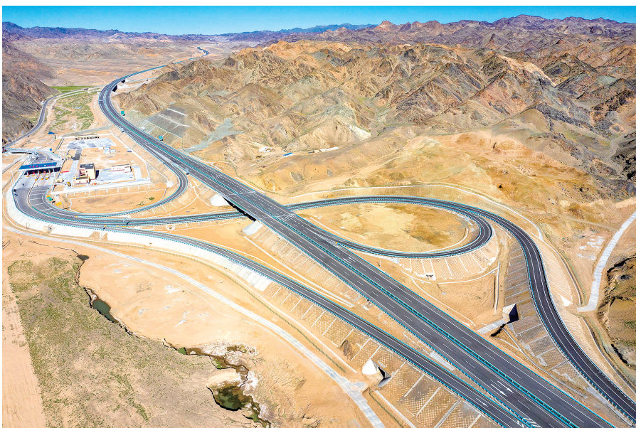
这是在巴里坤哈萨克自治县下涝坝乡拍摄的京新高速公路(6月28日摄,无人机照片)。新华社发
