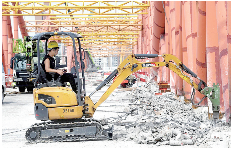
彩虹桥拆解现场
