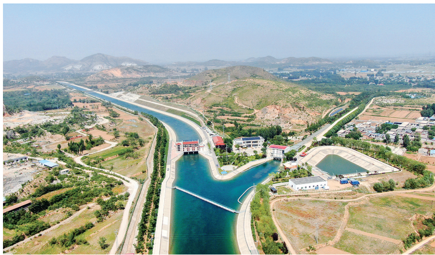
南水北调中线西黑山枢纽,一分为二流往北京和天津 新华社发
