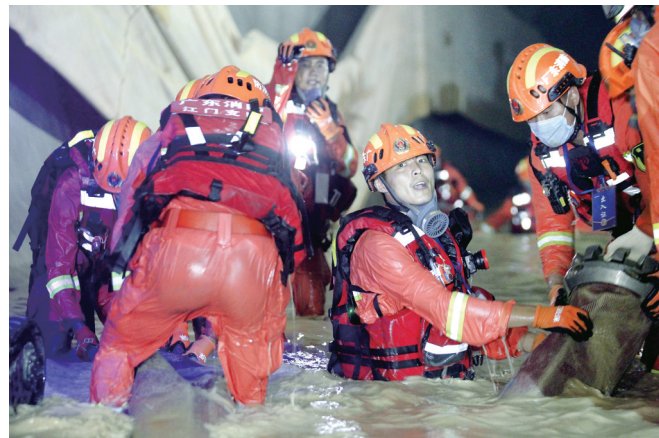
救援人员把排水设施向隧道深处推进 新华社发
