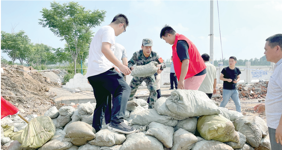
7月24日上午,贾鲁河韩寺镇被冲跨的荣庄桥段重新合龙。通讯员 张佩瑶 图
