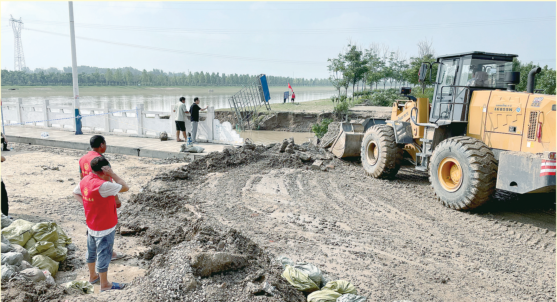
7月24日上午,贾鲁河韩寺镇被冲跨的荣庄桥段重新合龙。通讯员 张佩瑶 图
