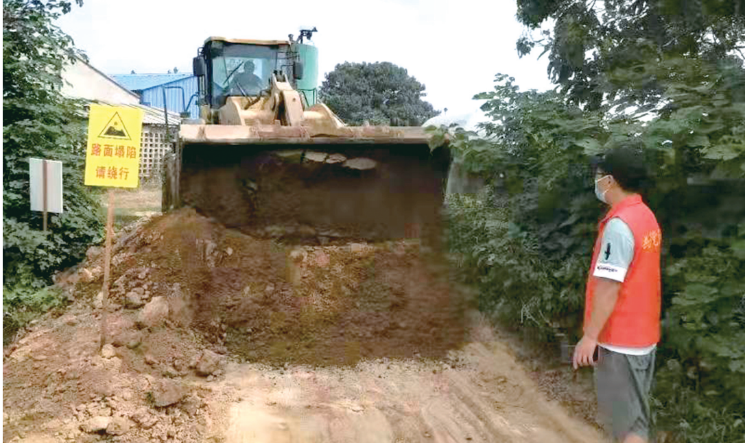
抢修塌陷路段
