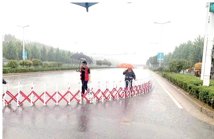
长椿路涵洞封闭
