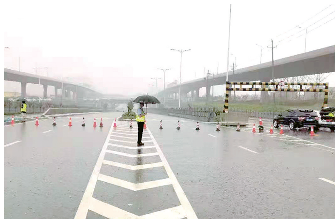
西四环陇海铁路桥涵洞南北封闭
