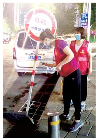
设置积水警示标识、路面清扫、人工捡拾等工作,及时清扫道路积水及下水道井篦子,确保疏通道路两侧排水管网畅通,提高排涝行水能力。
