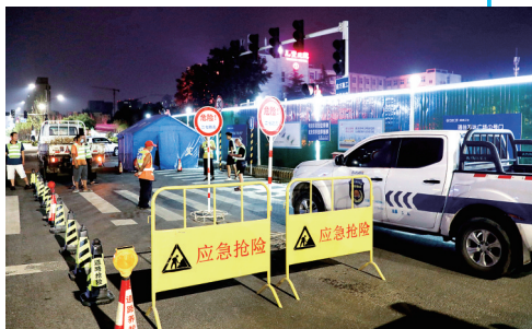
全区28支防汛抢险队伍随时待命
