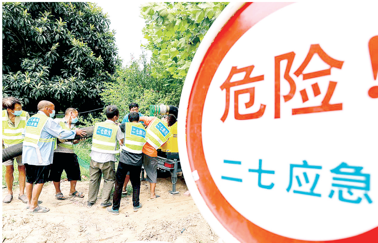
安装发电机、抽水泵
