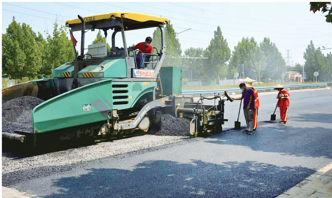
郑州路桥集团灾后重建施工现场一派热火朝天的忙碌景象
