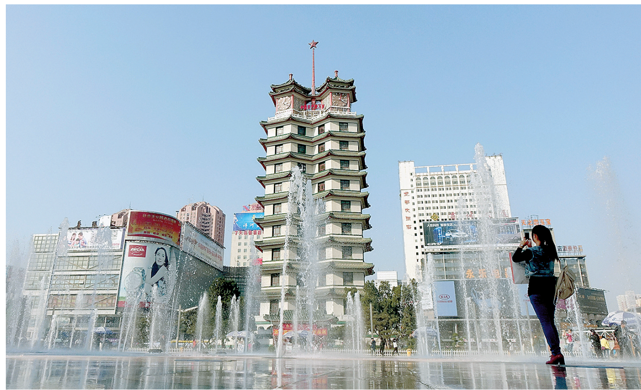
二七纪念塔、二七纪念堂维修工程完工,恢复对外开放
