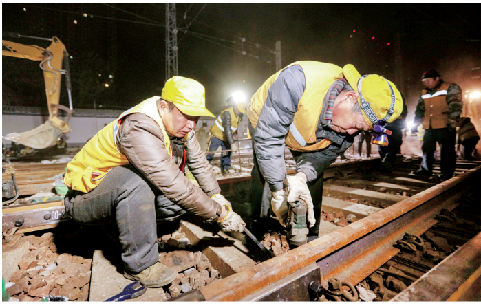
拆除“服役”到期的道岔
