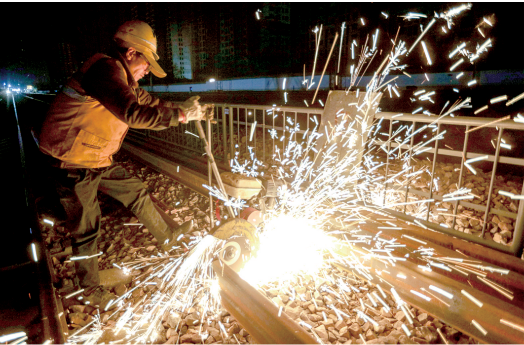
切割旧道岔作业
